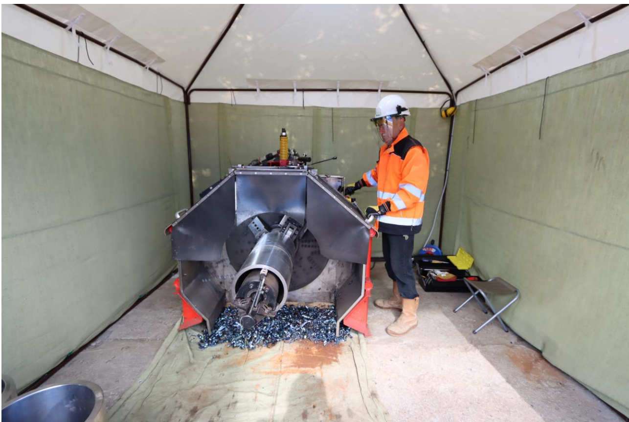
Палатка № 6 для механической обработки кромок труб под сварку станком РМ с гидроприводом
