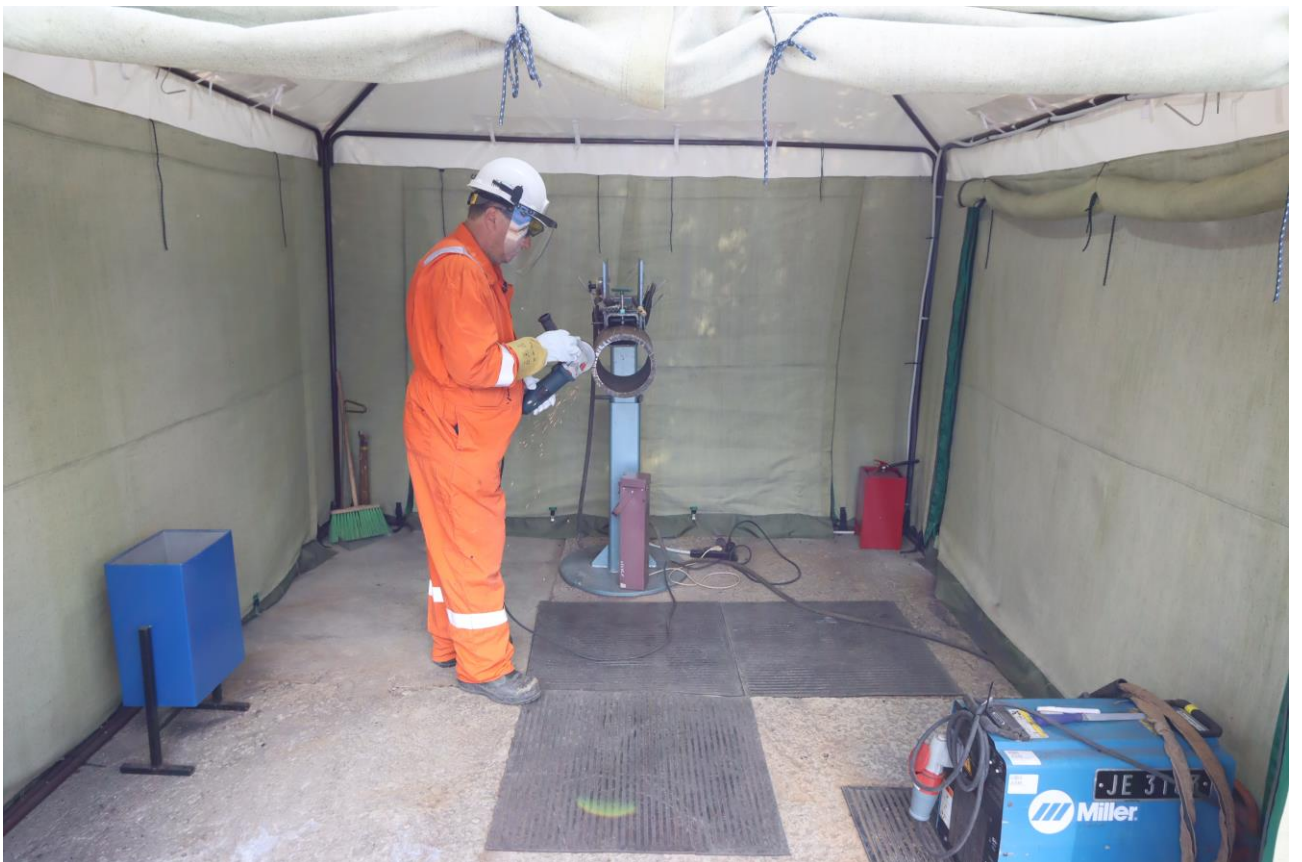
Сварочная палатка № 2 для ручной дуговой сварки КСС в положении Н45, ремонта сваркой
