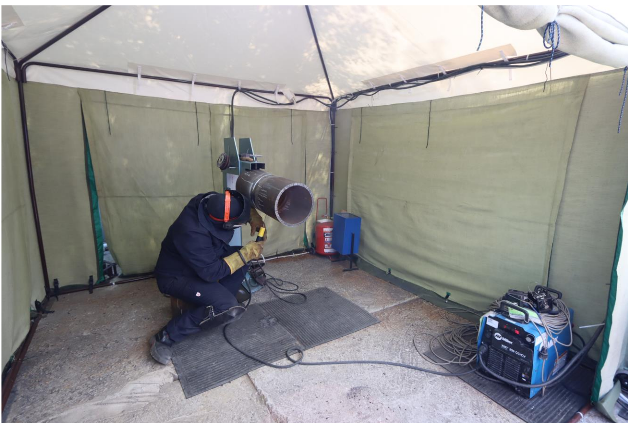
Сварочная палатка № 5 для ручной дуговой сварки КСС в положении Н45, ремонта сваркой, воздушно-плазменной строжки
